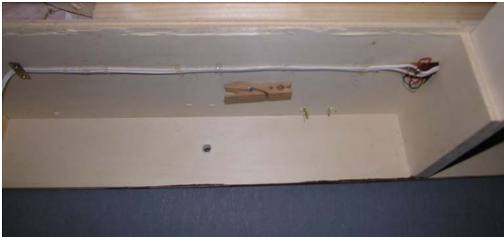
Abbildung 6: Wäscheklammer zur Kabelaufhängung während des Transportes
